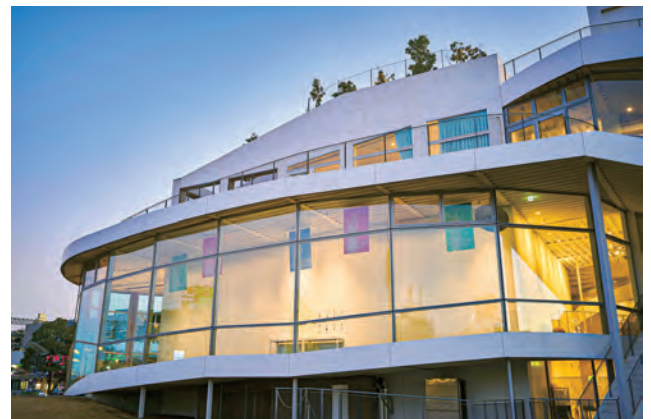
スロープ 北側壁面
