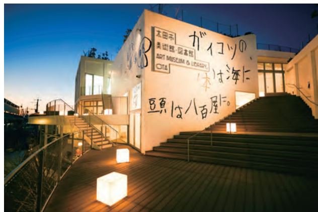
南側外壁 《ガイコツ!!》、《頭ガイコツの生活》(カッティングシート)
